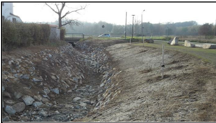
Abb. 4: Maltengraben nach der Maßnahme: Naturnah befestigtes Gewässerbett, 23.11.2018
