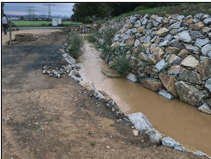
Abb. 5: Maltengraben nach Maßnahme: Umgestalteter Gewässerabschnitt nach Regenfällen, 24.09.2018
