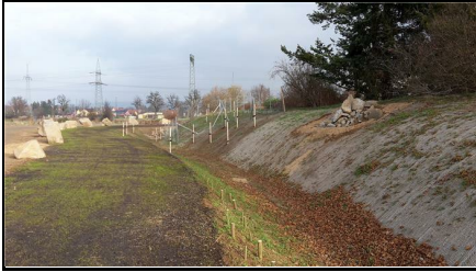
Abb. 3: Maltengraben nach Maßnahme, naturnaher Gewässerverlauf in Tieflage, 23.11.2018
