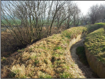
Abb. 2: Maltengraben vor der Maßnahme: Hochlage und harter Ausbau, 12.03.2014
