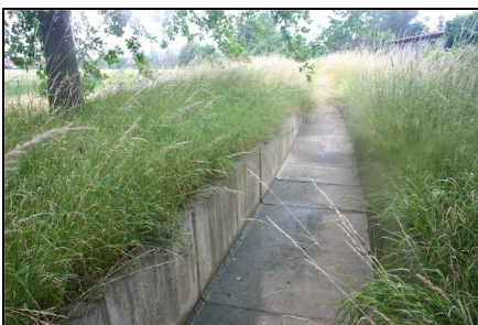
Abb. 1: Gewässerzustand vor der Maßnahme, 22.06.2009
